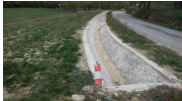
Fossé créé en 2022 en bordure de la route au Sud
