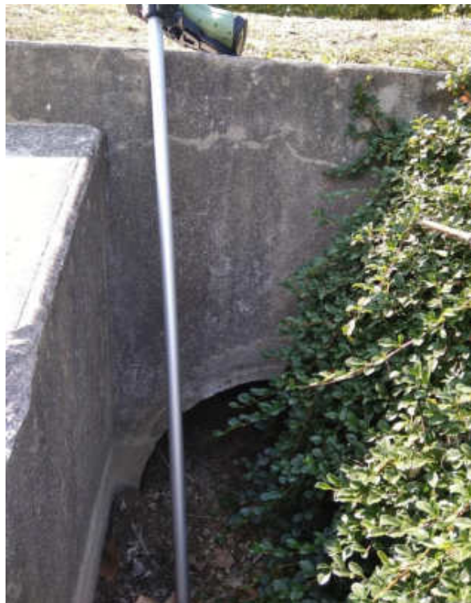
Figure 16 : ouvrage busé sous l'accès au Parc
