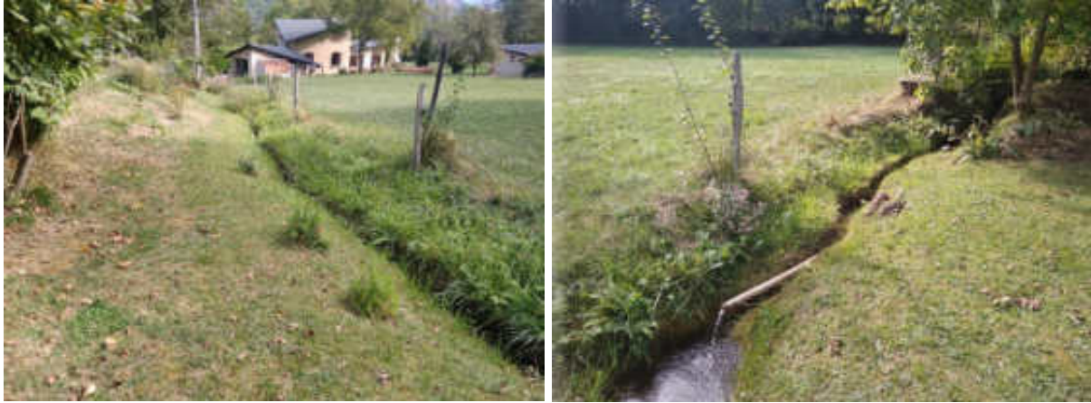
Figure 5 : Talweg de la Lauze avant la traversée de la RD23
