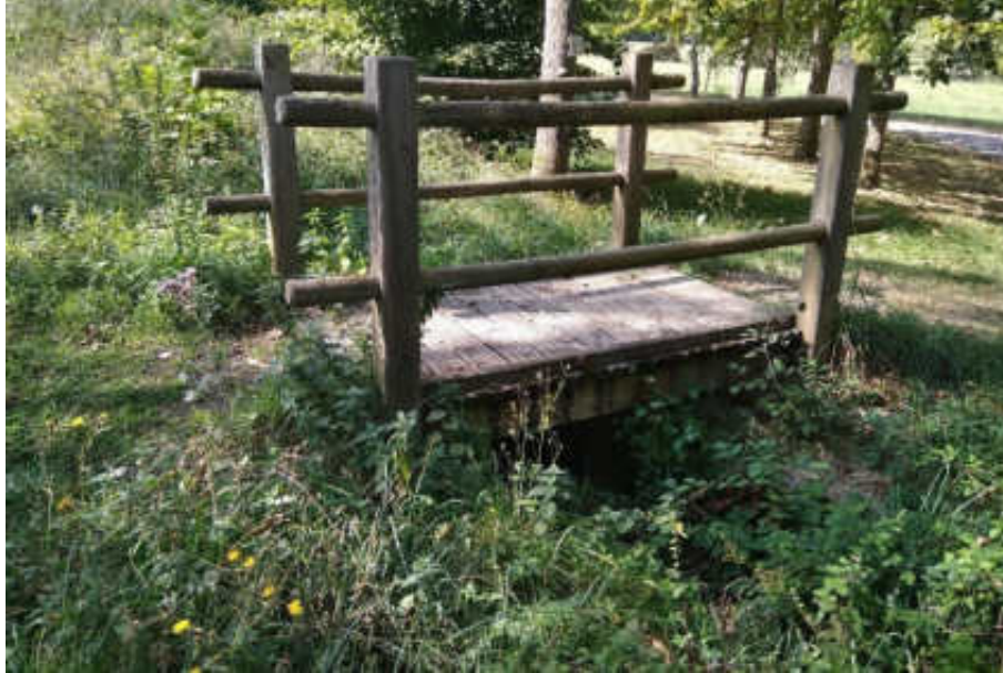
Figure 15 : passerelle piétonne entre la RD23 et le parking du Parc
