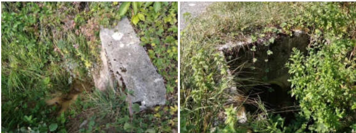
Figure 13 : entonnement amont (à gauche) et exutoire aval (à droite) du franchissement de la RD23
