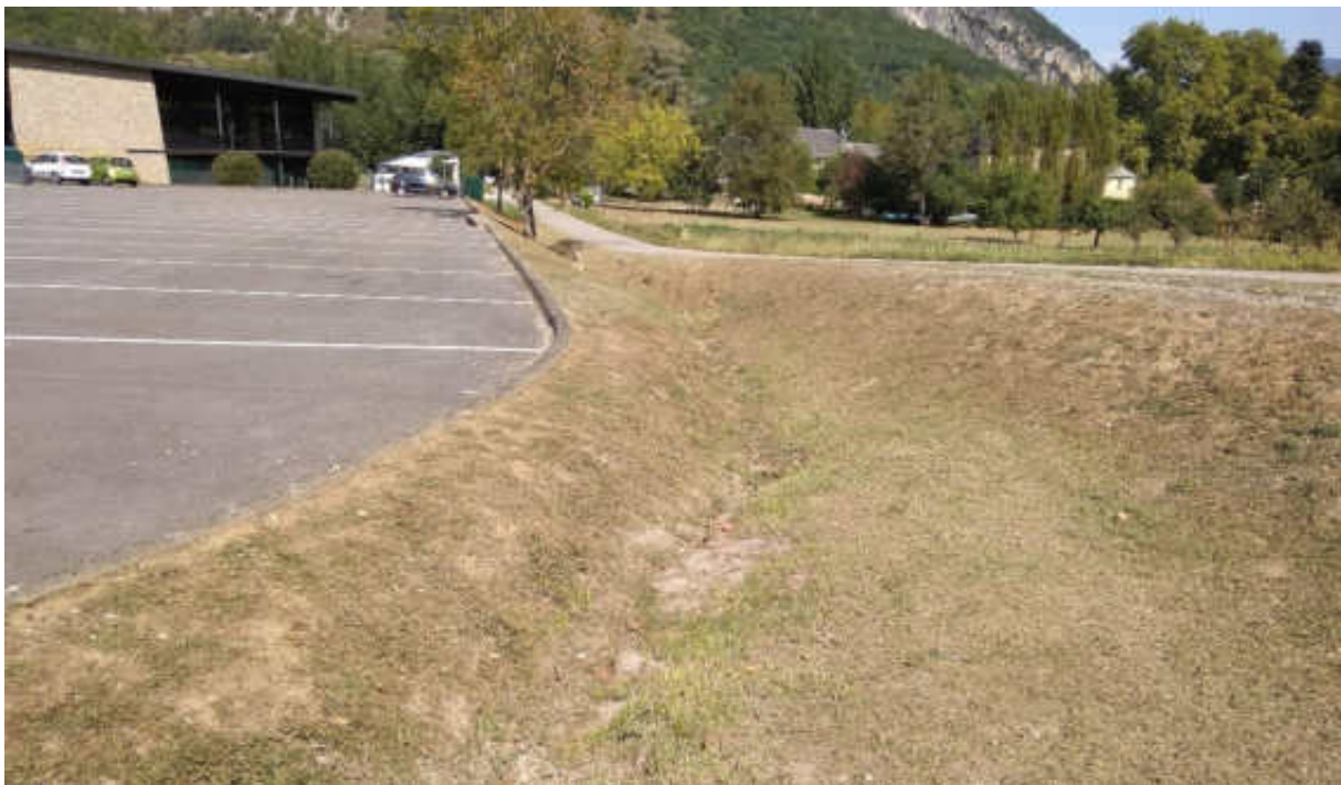
Figure 12 : fossé en terre bien entretenu recueillant la totalité des eaux pluviales du secteur du Parc et les écoulements résiduels du talweg
